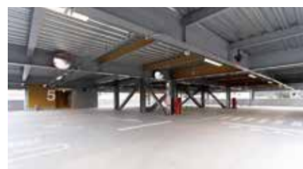
一台一台の駐車スペースは広く取られているので、安心して駐車できます。
