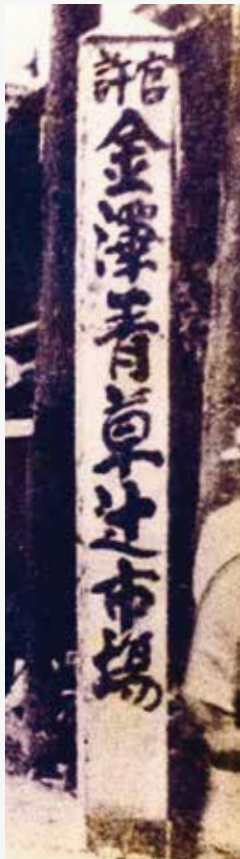
↑ 明治に建てられた標柱
